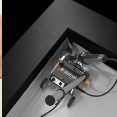
▲ Dachbahnen schweißen HG ROOF
